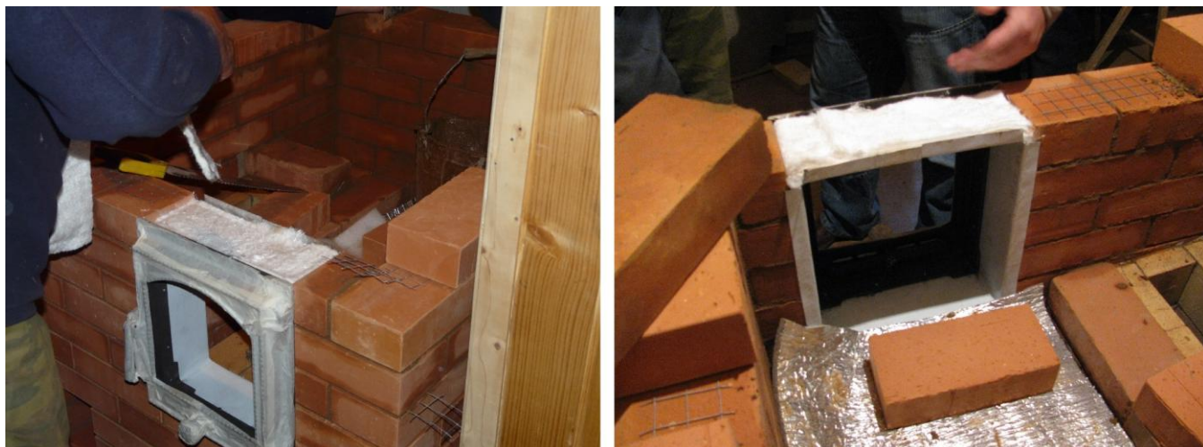
Pav. 6. Krosnių įrangos montavimas krosnies montavimo metu.
