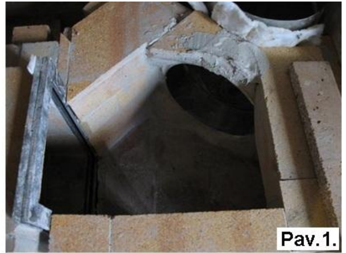
Pav. 1. Plieninio trišakio prijungimas, naudojant keraminę vatą.
