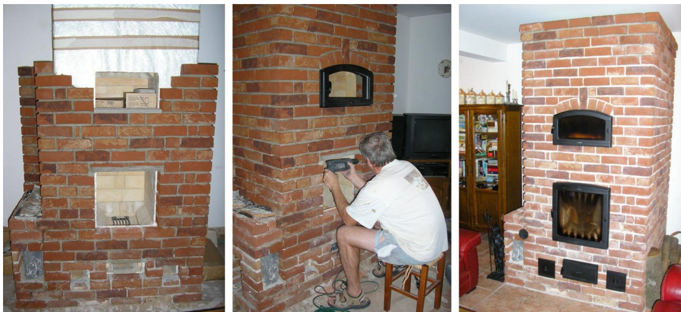
Pav. 5. Krosnių įrangos montavimas į sumontuotą krosnį.
