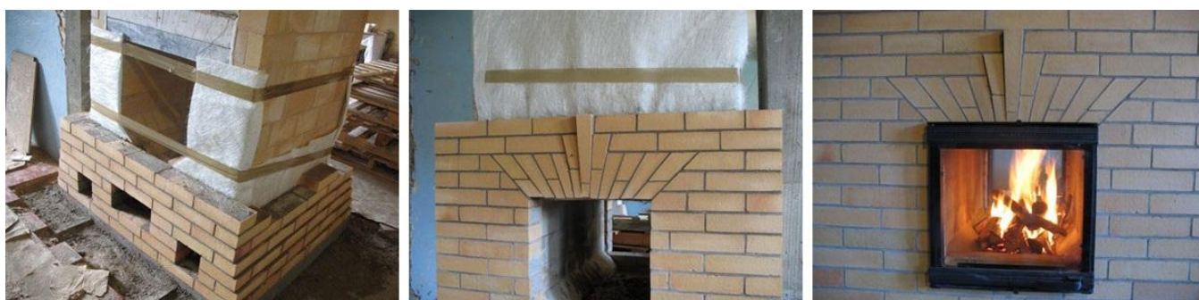
Pav. 4. Vata tarp vidinio plytų vainiko ir apdailos plytų.
