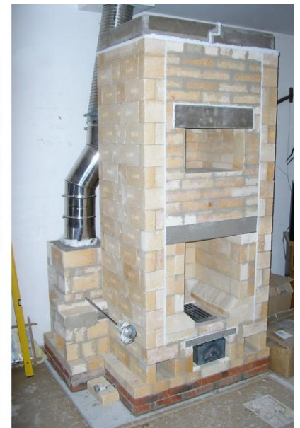
Pav. 2. Keraminė vata ir skirtingą plėtimosi koeficientą turinčios medžiagos.
