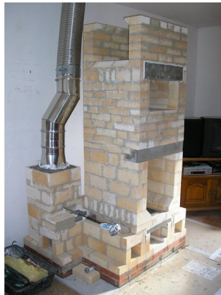
Pav. 2. Keraminė vata ir skirtingą plėtimosi koeficientą turinčios medžiagos.
